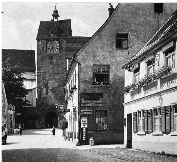
Gasthaus zur Krone in der Bahnhofstraße
